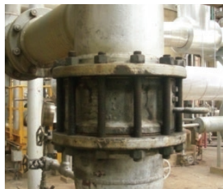
Válvula con y sin la instalación de Protector de Fuego FIRESAFE® .
