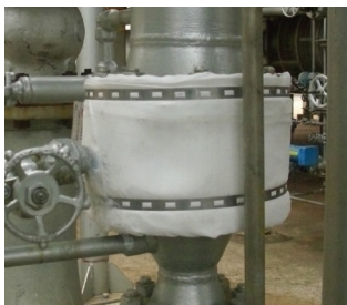
Válvula con y sin la instalación de Protector de Fuego FIRESAFE® .
